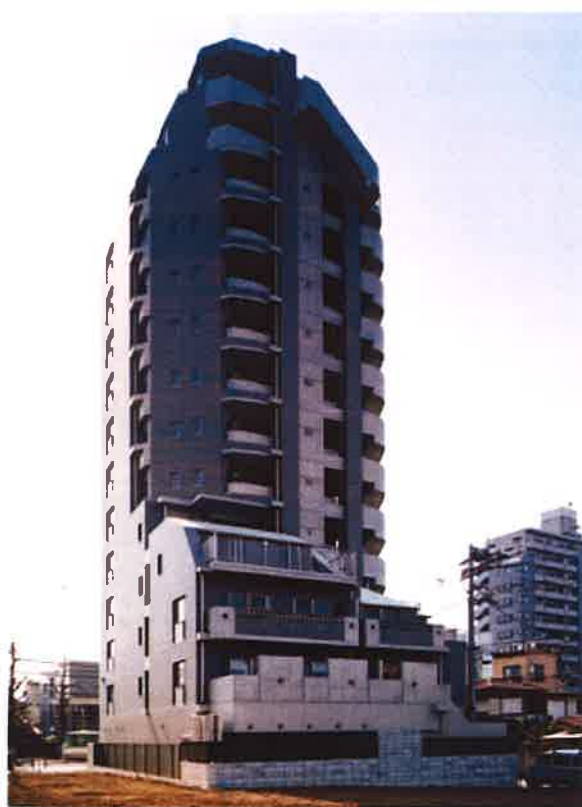
(仮称)向丘マンション ー平成15年3月竣工ー
