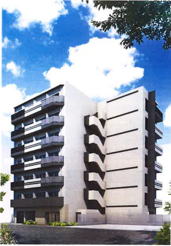
(仮称)森下マンション 一令和3年3月竣工
