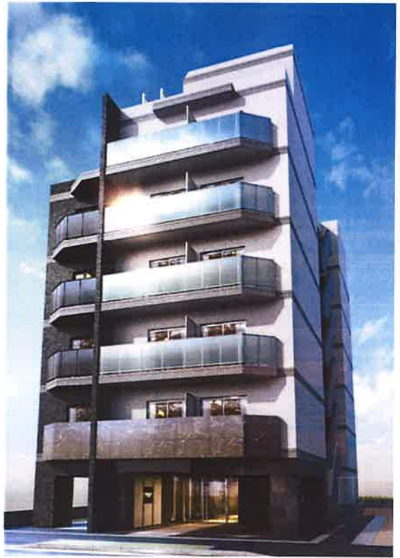
(仮称)梅島1丁目マンション 一令和5年9月竣工
