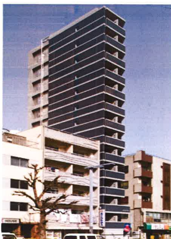
(仮称) 西新宿5丁目マンション ー平成18年3月竣工ー
