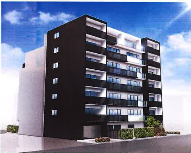
(仮称) 本所4丁目マンション ー平成30年6月竣工ー
