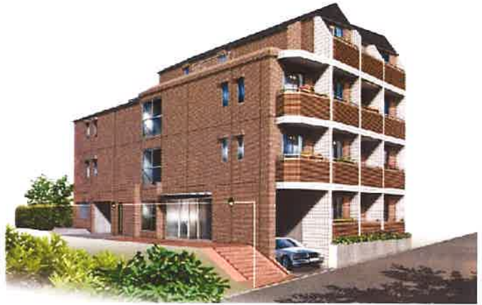
(仮称)上馬2丁目マンション ー平成15年12月竣工ー
