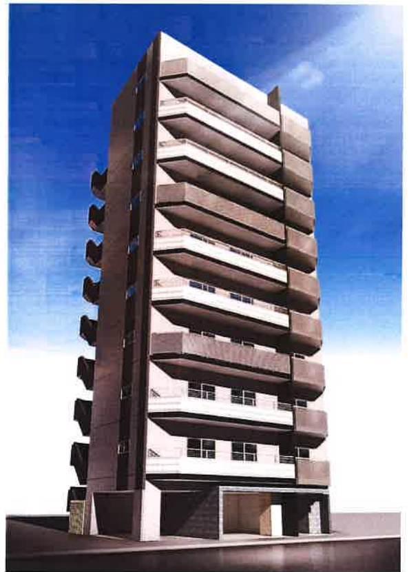
(仮称) 小島1丁目マンション ー令和1年8月竣工ー
