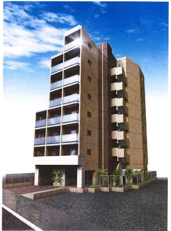
(仮称) 戸越公園マンション ー平成25年10月竣工ー
