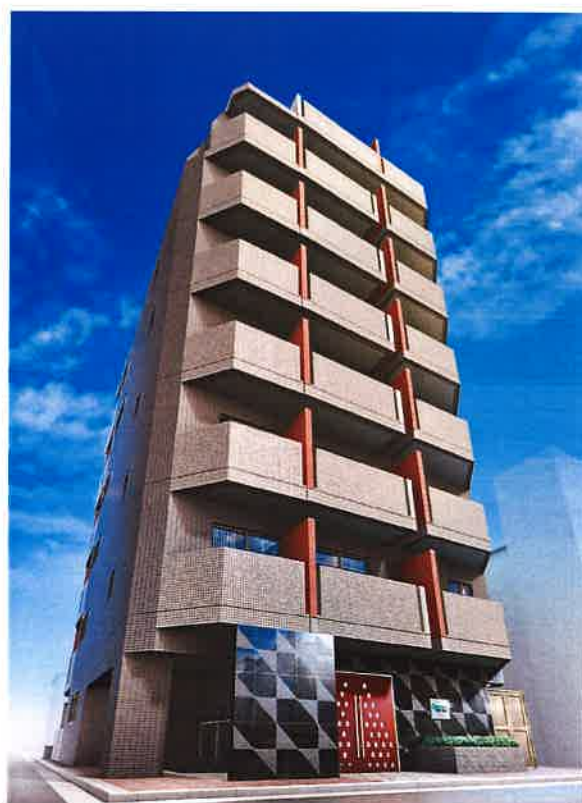
(仮称)滝野川6丁目マンション ー平成21年3月竣工ー
