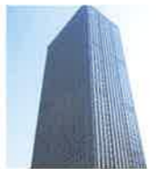
新宿センタービル
